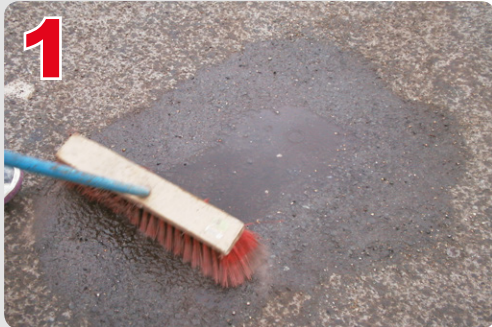
1 Met een bezem wordt water en los vuil van het wegdek geveegd
